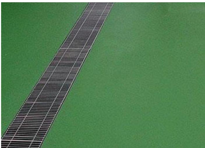
ウェットエリアの場合には、床面に設けた排水溝、排水柵に向かって1/50～1/100程度の勾配を設けるなど、水たまりをつくらないようにします。また、排水溝や排水柵の蓋はメンテナンス上容易に開け閉めできるように作業台や機械の下にならない配置にします。
